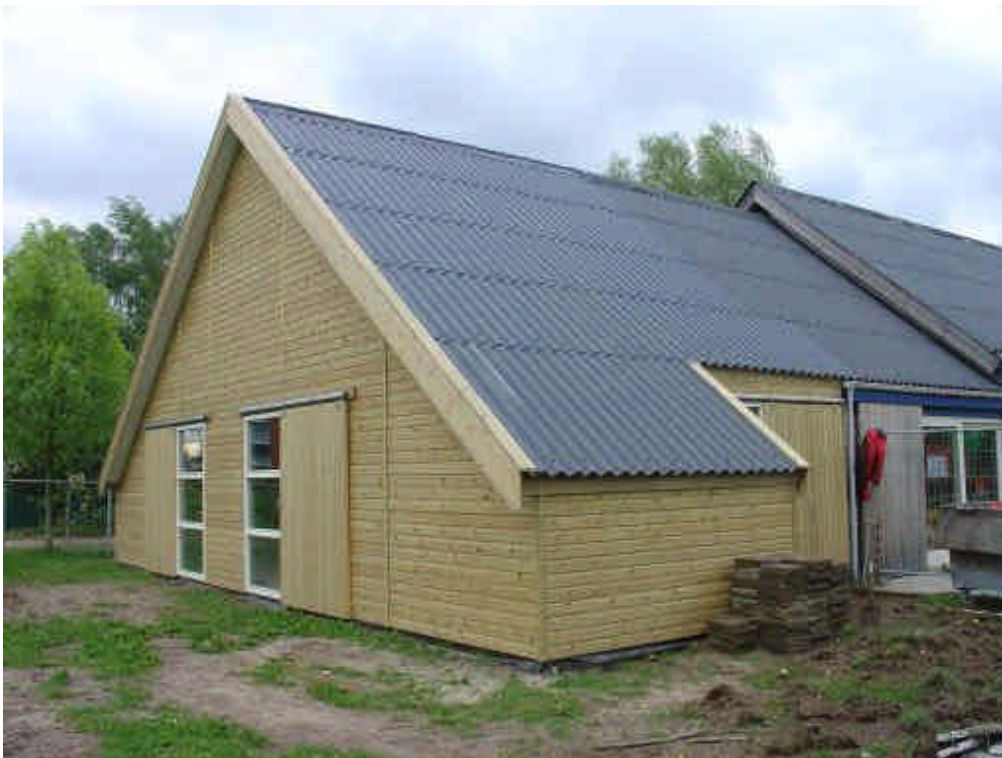
Aanbouw 3 e lokaal, maart 2004
